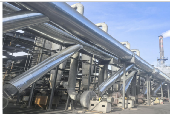
炉尾尾气管道改造后
