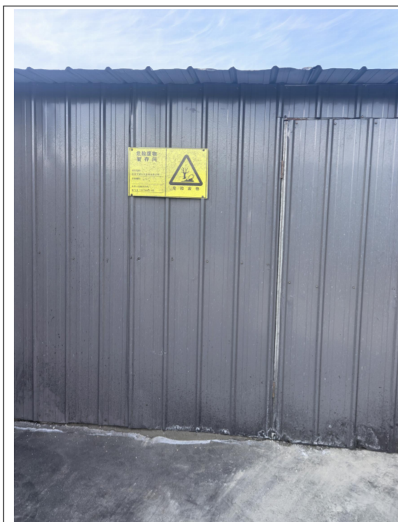
危险废物暂存库
