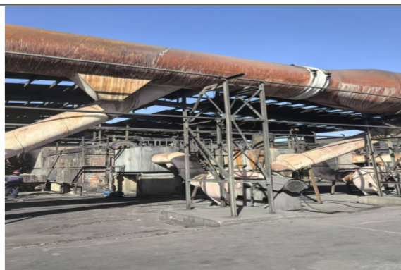
炉尾尾气管道改造前
