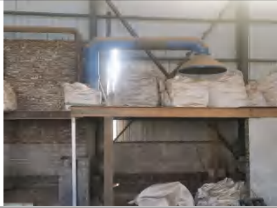
落砂工艺集气罩
